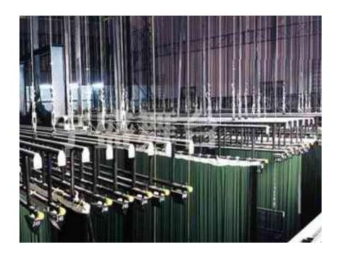
舞台防火隔离幕共由幕体部分、平衡重力系统驱动、阻尼系统、水帘装置和滑轮等部分组成。
